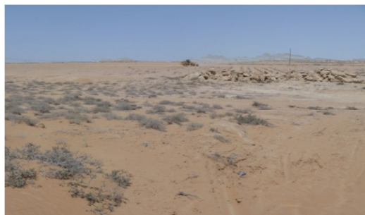
شکل (۴): تسطیح مزرعه بریس توسط یکدستگاه لودر
