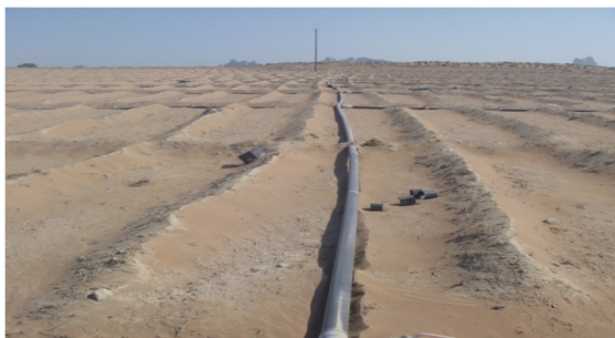
شکل (۱۰): عملیات اتصال لوله شبکه اصلی و فرعی در مزرعه بريس
