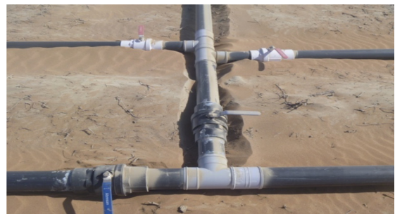
شکل (۱۰): عملیات اتصال لوله شبکه اصلی و فرعی در مزرعه بريس
